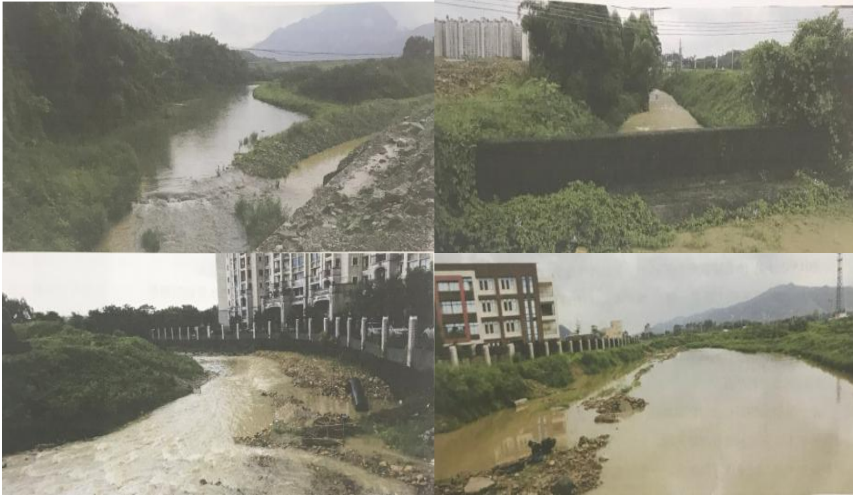
附图三：项目现状情况照片
