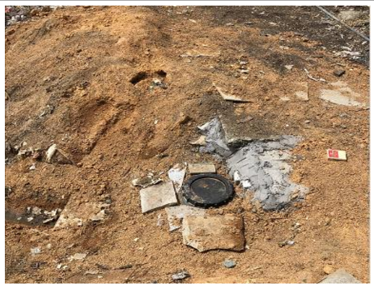
整改增加暂存池及抽水设施
