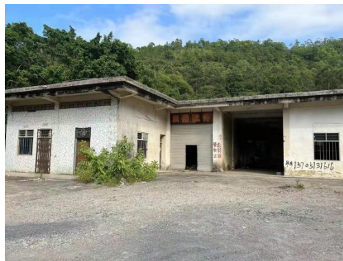
图 3-1 项目西北面 35m 荒废建筑物现状
