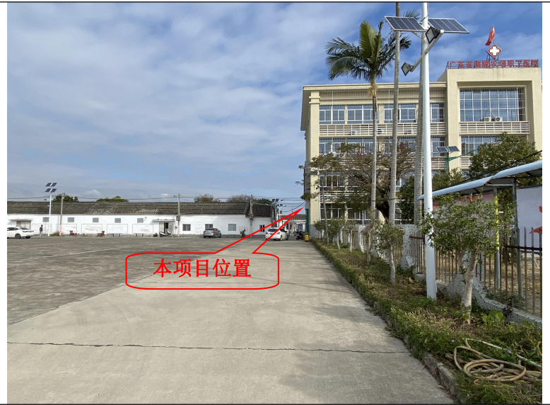
项目西面环境照片
