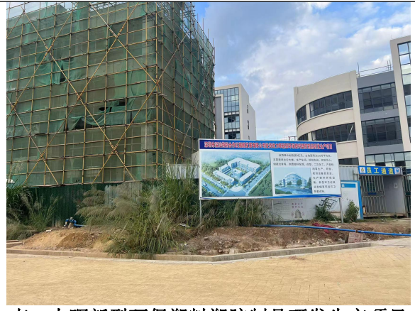
南，力晖新型环保塑料塑胶制品研发生产项目在建厂房
