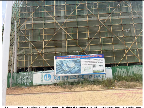
北，海丰高迪装配式整装研发生产项目在建厂房
