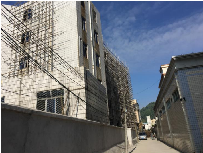
项目东侧厂界
