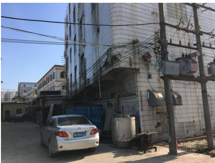
项目北侧厂界
