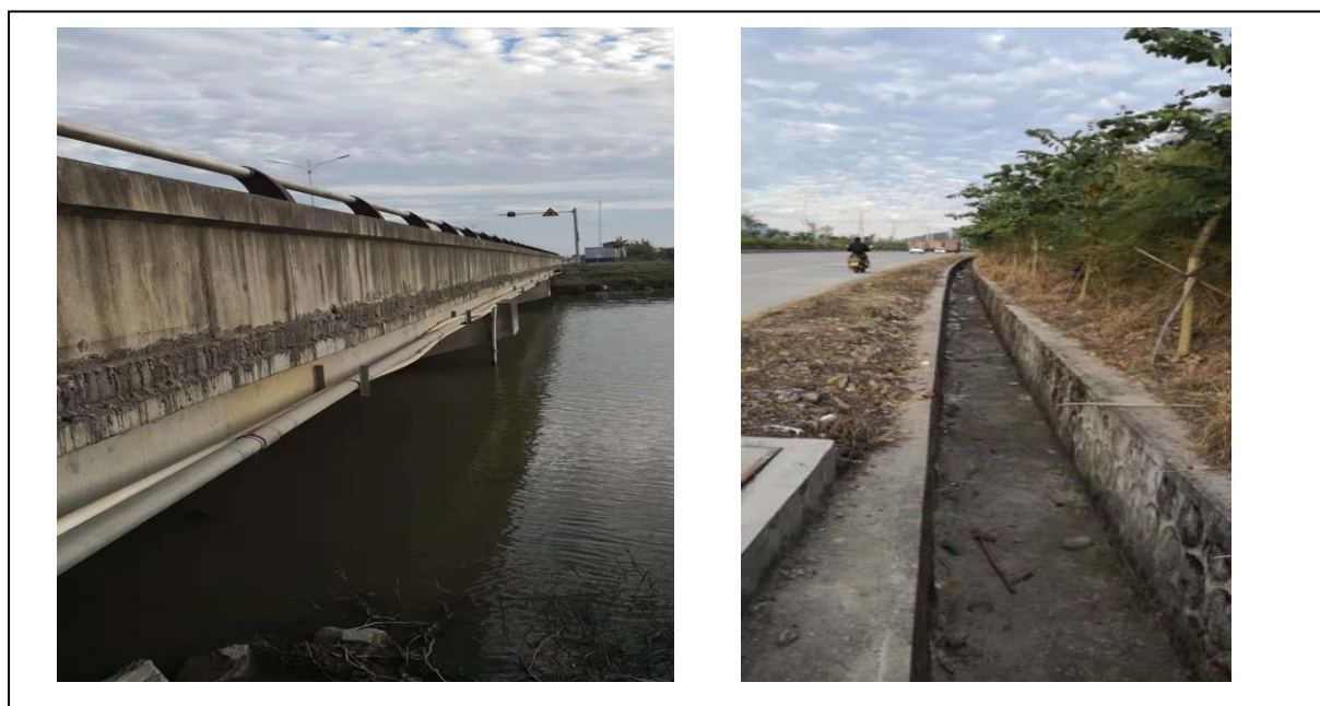
图 5-3 排水设施现状
