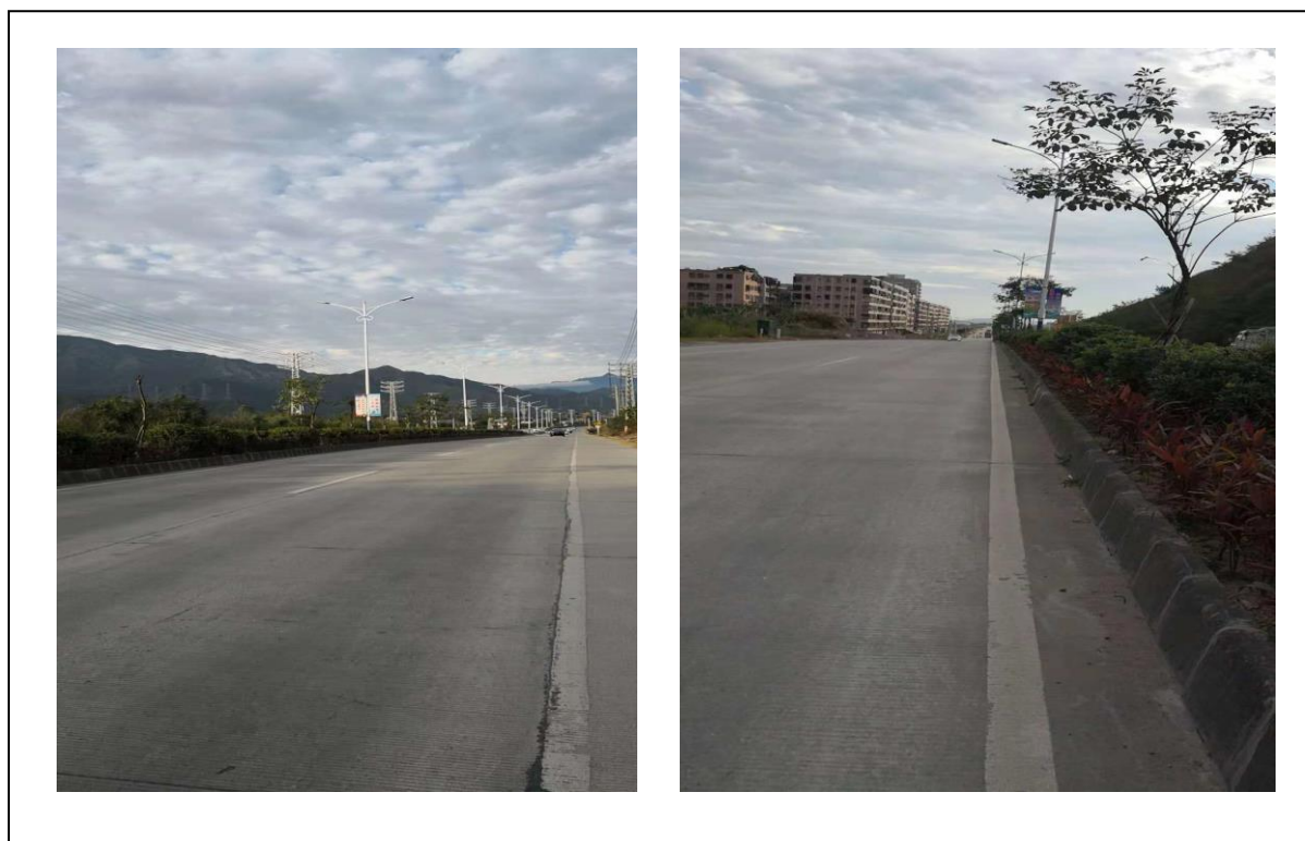
图 5-4 绿化工程现状
