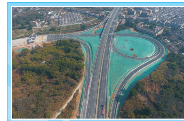
▲ 汕湛高速汕头至揭西段普宁西互通苫盖措施
