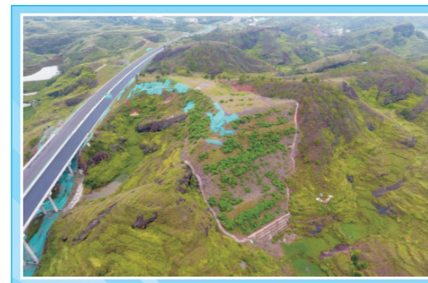
▲ 兴宁至汕尾高速公路五华至陆河段弃土场治理措施
