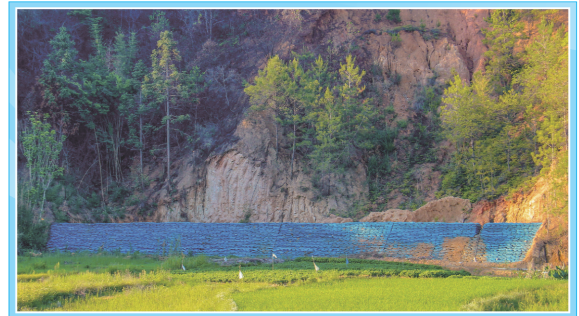
▲ 崩岗治理 (生态袋谷坊工程)
