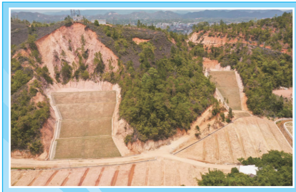
▲ 崩岗治理 (拦沙坝)
