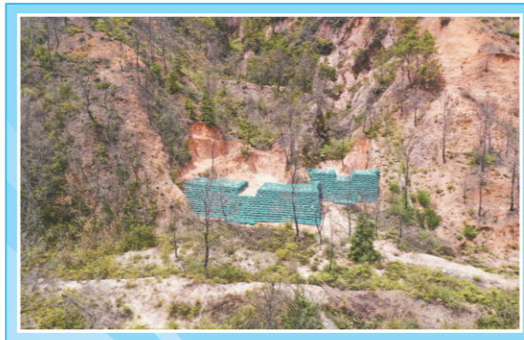
▲ 崩岗治理 (生态袋谷坊工程)
