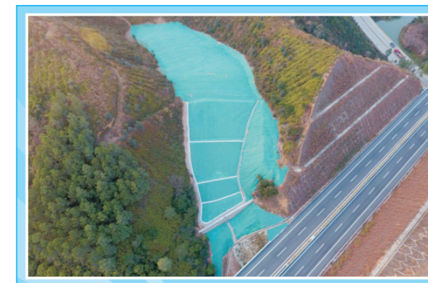
▲ 河（源）惠（州）（东）莞高速公路龙紫金至惠阳段弃渣场治理措施
